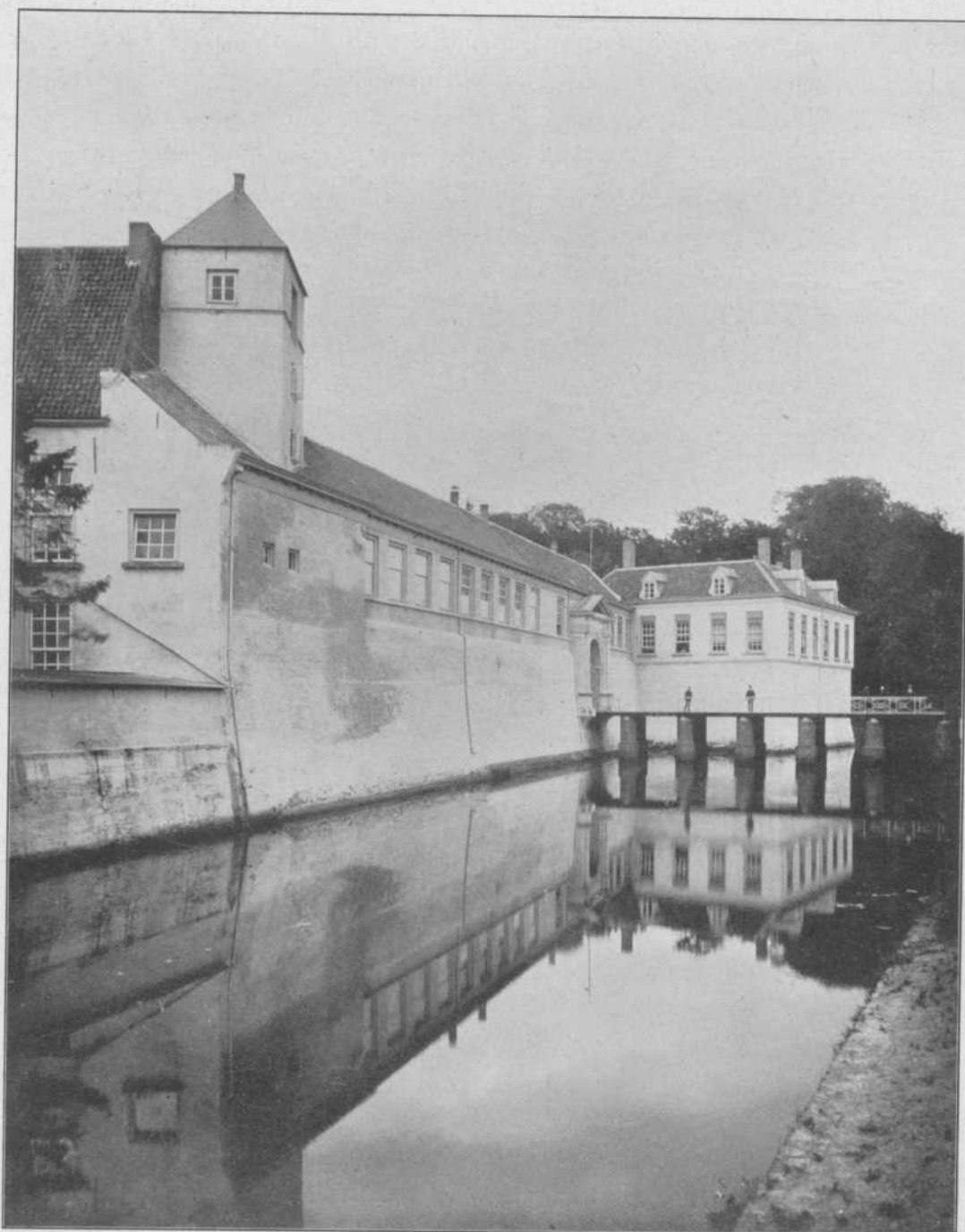
De muur aan de stadszijde, vermoedelijk dagteekenende uit omstreeks 1400. (Op den muur werd later eene galerij gebouwd, die tegenwoordig tot gesloten vertrekken is ingericht).
